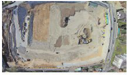
Das Areal ist nun komplett sauber und bereit für die Realisierung der Siedlung Steinreben.
